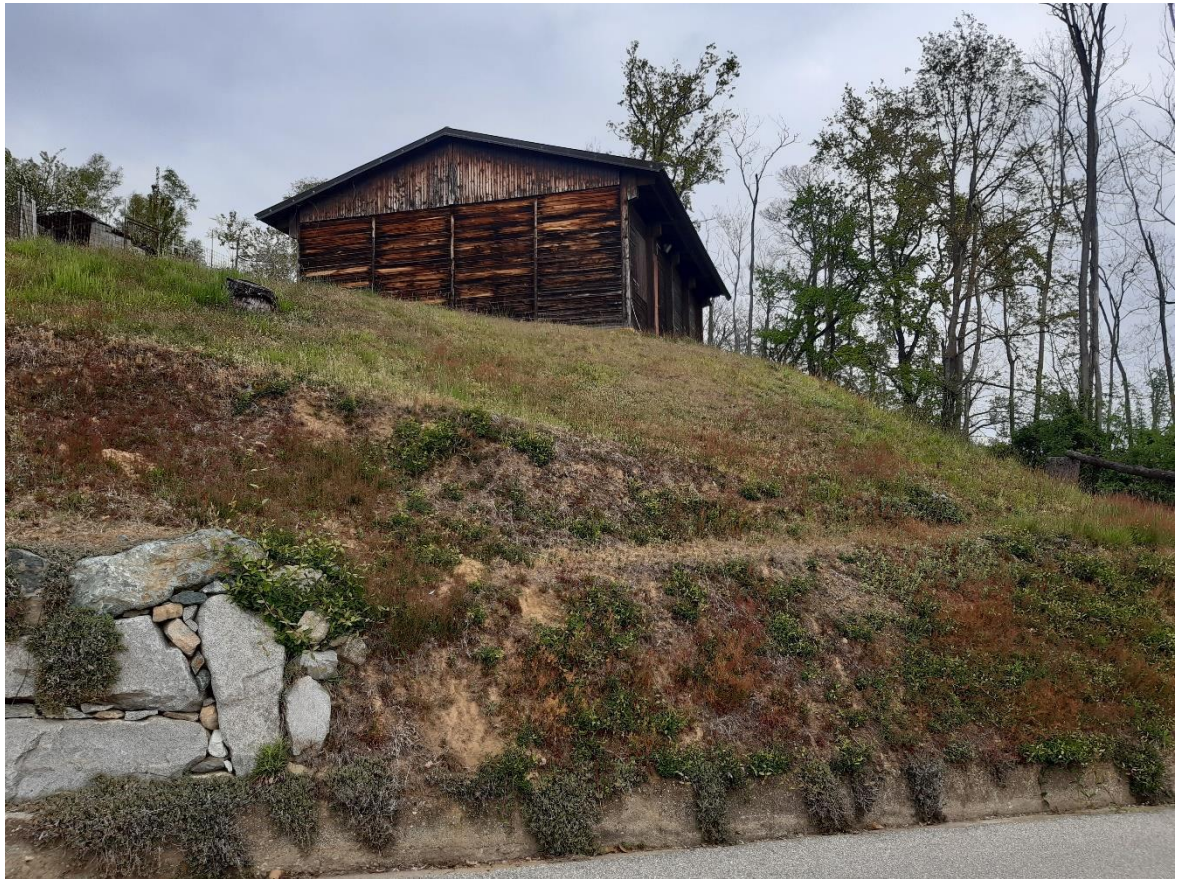
VISTA FOTOGRAFICA SUD, DALLA VIABILITA', DELL'AMBITO INTERESSATO
