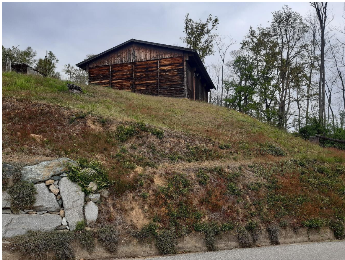
VISTA FOTOGRAFICA SUD, DALLA VIABILITA', DELL'AMBITO INTERESSATO
